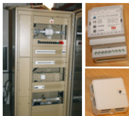
Komponentene i og utenfor sikringsskap
